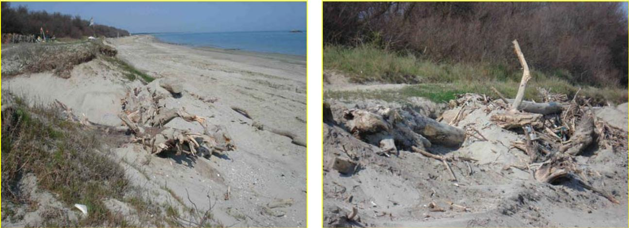
Figure 29 - Quelques phases de positionnement des restes végétaux sur le flanc marin du cordon dunaire.
