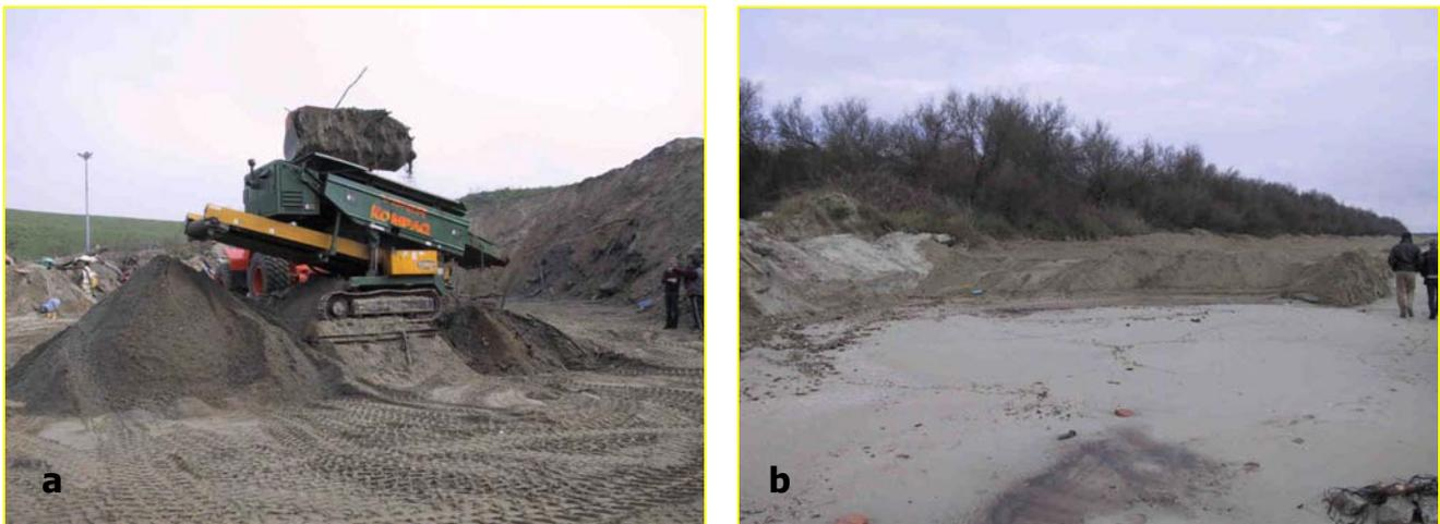
Figure 28 - Tamisage du sable (a) et phase de versement du matériel sur la plage (b).
