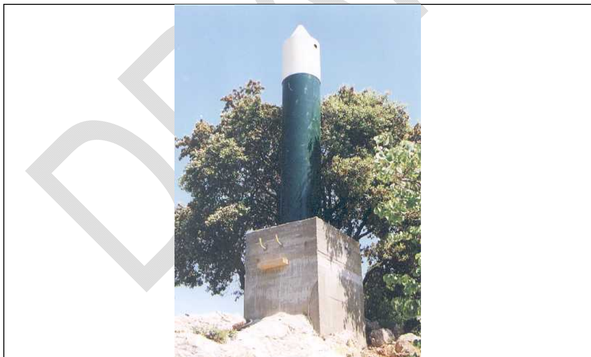
Station GPS permanente de Montpellier, pilier géodésique et antenne au sommet (sous radôme conique blanc)
