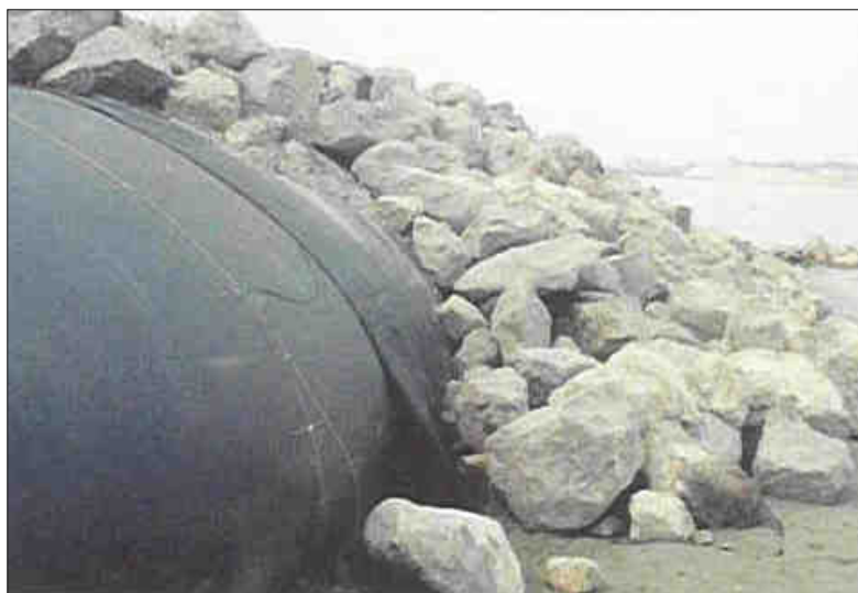
Fig. 13 - Geotessuto a protezione meccanica del Geotubo
