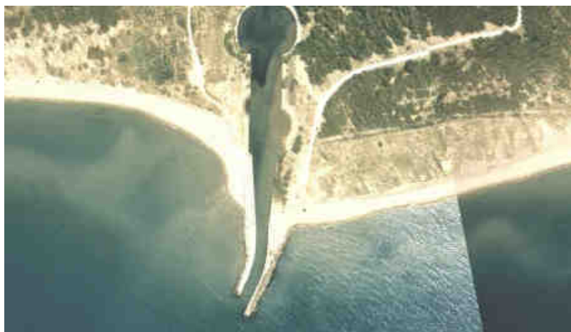
Foto 4 - Pennelli alla foce del Fiume Morto Nuovo (ripresa aerea del luglio 2004)
