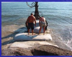
Intervento di manutenzione straordinaria "setto 4" consistente nel rifacimento della radice del setto con la messa in opera di 200 nuovi sachi. L'intervento è stato completato con il versamento di 3.300 t di ghiaia 3-7 mm e di 2.700 t di ghiaia 7-15 mm.
