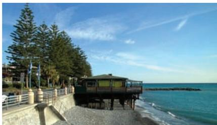
Fig. 3.1.4 - Erosione della spiaggia a Bordighera (IM).
